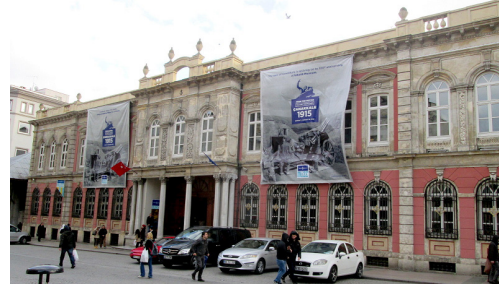
Şekil 2. İş Bankası Müzesi 2000-2002 Yılları Arasındaki Renovasyon Çalışması- (Binaya ek yük getiren üst 2.5 kat alınmış, asansör iptal edilmiş ve tüm taşıyıcılar güçlendirilmiştir 5 )
