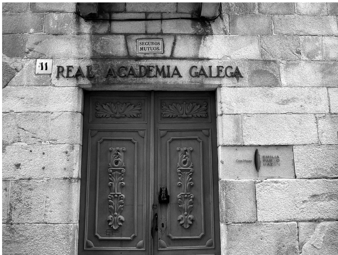
Edificio da Real Academia Galega, A Coruña.
