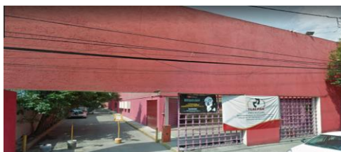
Fig. 1. Fachada principal de la Biblioteca Pública Central Delegacional de Tlalpan.
