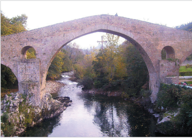
Puente romano de Cangas de Onís, capital del antiguo Reino de Asturias https://upload.wikimedia.org/wikipedia/commons/b/b8/Puente_Romano_de_Cangas_de_Onís.jpg
