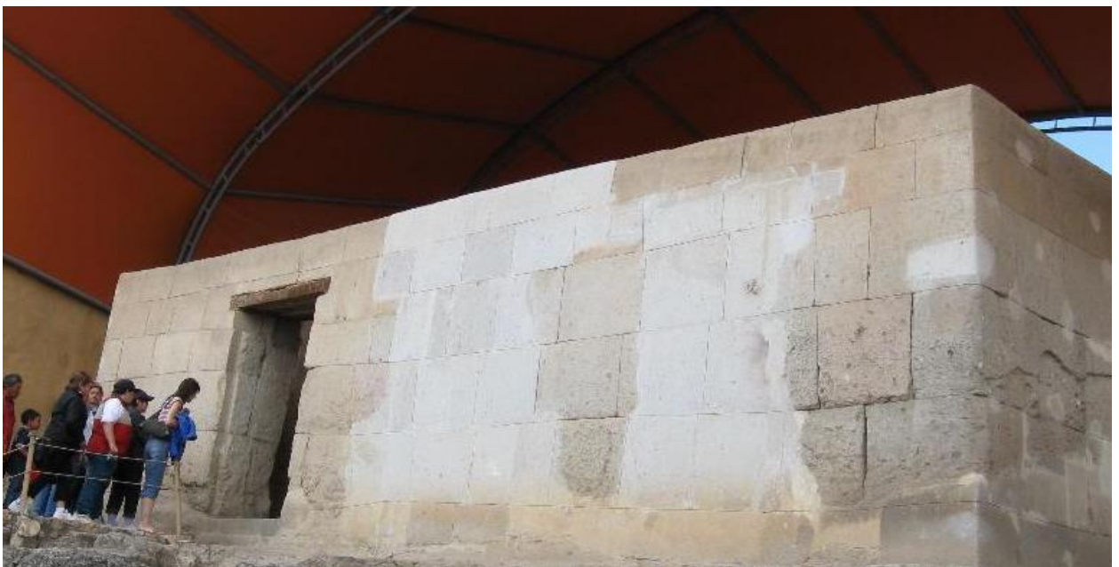
Figura 11. Fotografía del cuarto de rescate, en la ciudad de Cajamarca
